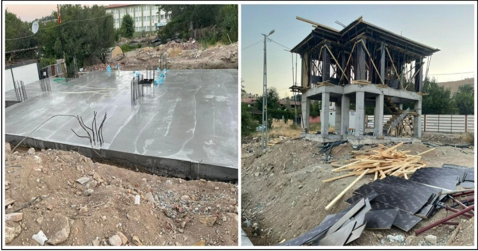
Fotoğraf 10. Hamidiye Mahallesi köy evleri inşaatı (Temmuz 2025)
