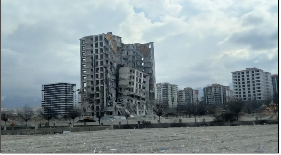
Fotoğraf 4. Bostanbaşı Mahallesi dinamit ile patlatılarak yıkımı gerçekleştirilen evler (03.09.2024)
