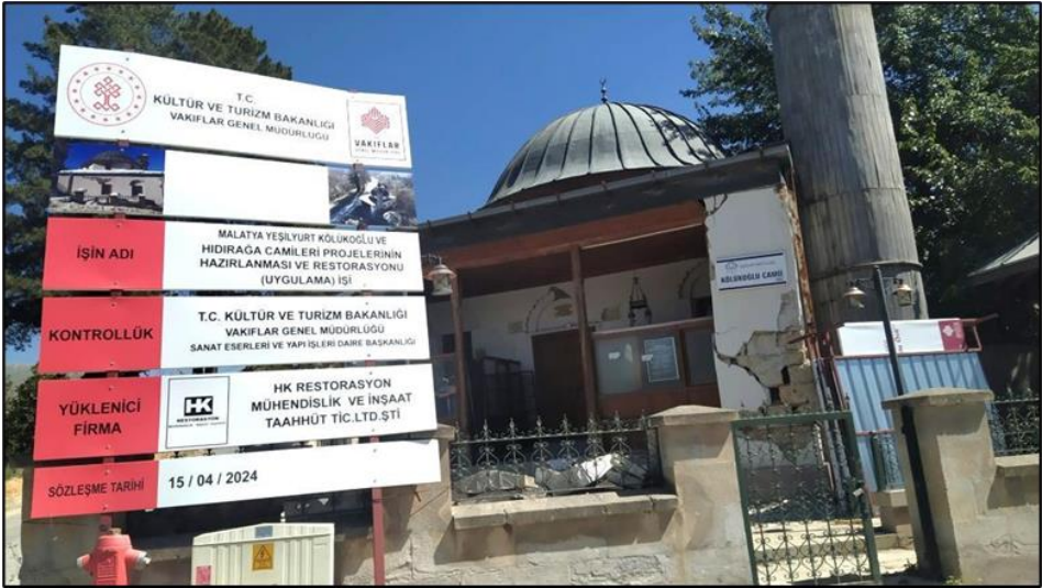
Fotoğraf 12. Hicri 1338 (M. 1920) yılında yapılan Külükoğlu Camii depremde ağır hasar almış ve 2024 yılında restorasyon çalışmalarına başlanılmıştır.
