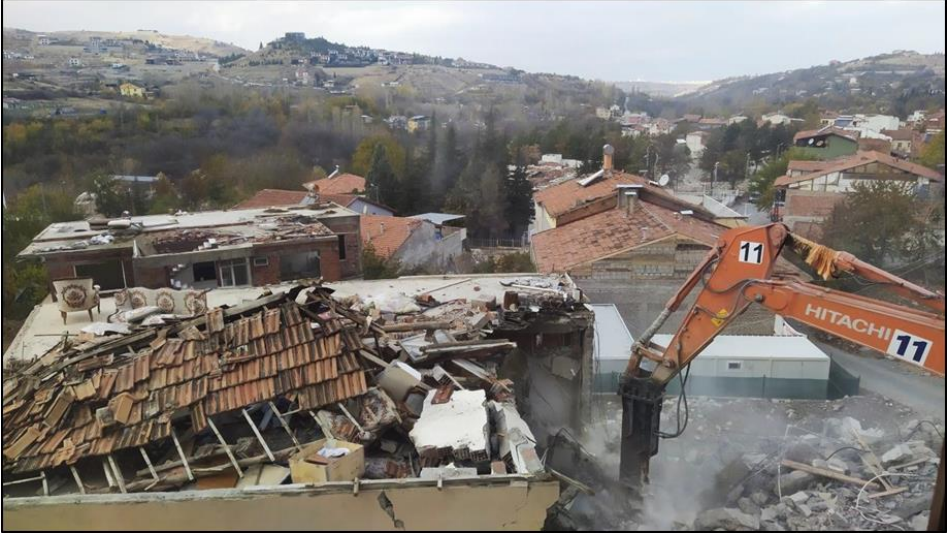
Fotoğraf 2. Hıroğlu mahallesi yıkım çalışmaları (Kasım, 2023)
