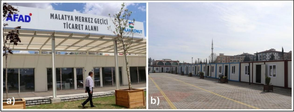
Fotoğraf 16. a) İnönü Mahallesi Geçici Ticaret Merkezi b) Turgut Özal Mahallesi Konteyner Çarşı
