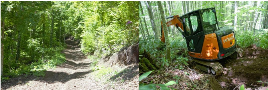
Şekil 1. Sürütme yolu ve mini ekskavatörle yapım çalışması
