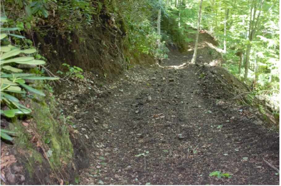
Şekil 1. Yeni yapımı tamamlanmış sürütme yolu
