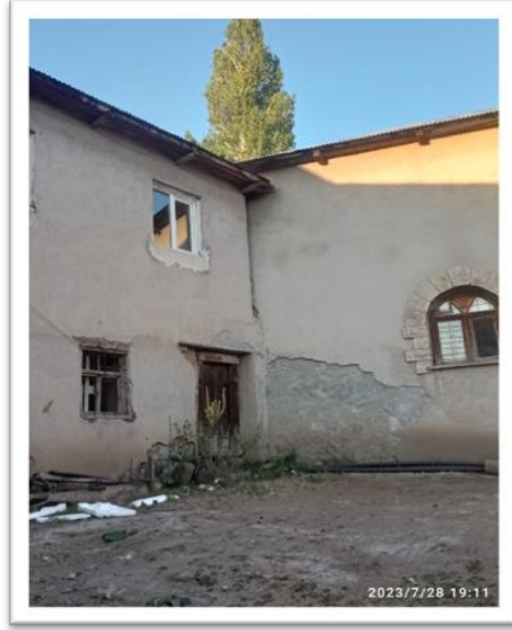
Şekil 4. İlk yapılan tek katlı caminin üzerine daha sonra çıkılan imam lojmanı ve yanına eklenti şeklinde yapılarak Kuran kursu olarak kullanılan ilave odalar
