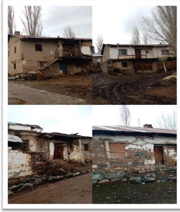
Şekil 5. Tek katlı ve iki katlı olarak inşa edilen kerpiç evler
