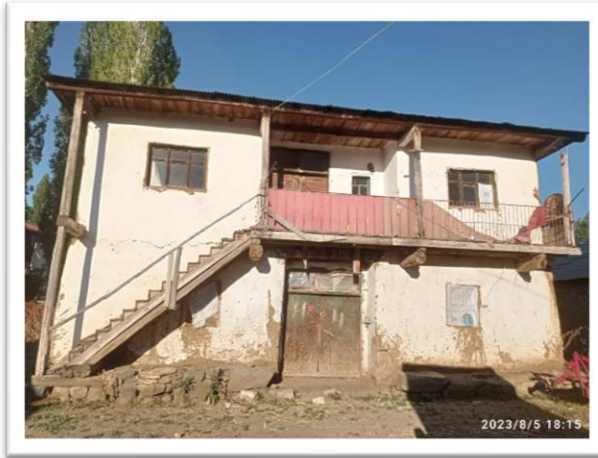
Şekil 6. İki katlı olarak inşa edilen kerpiç bir ev
