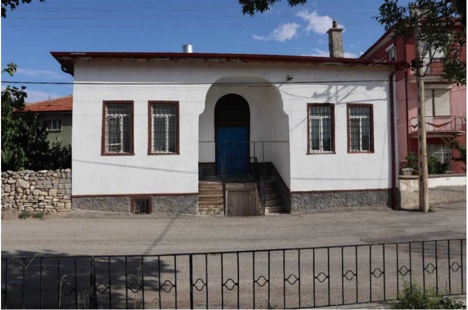
Resim-3: Mektebin (Recep Uzun Evi) kuzey cephesi
