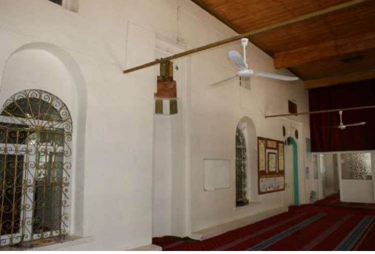
Ftg. 10. Yıldırım Beyazıt Camii. Son Cemaat Yeri. Kuzey Cephe.
