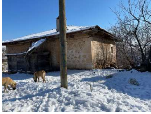
Fotoğraf 2. Selvioğlu Köyü Konağı. Kuzey ve Batı Cephe.
