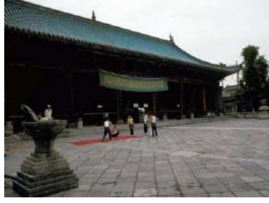
Resim 19. Caminin güneydoğudan görünümü ( https://www.archnet.org )
