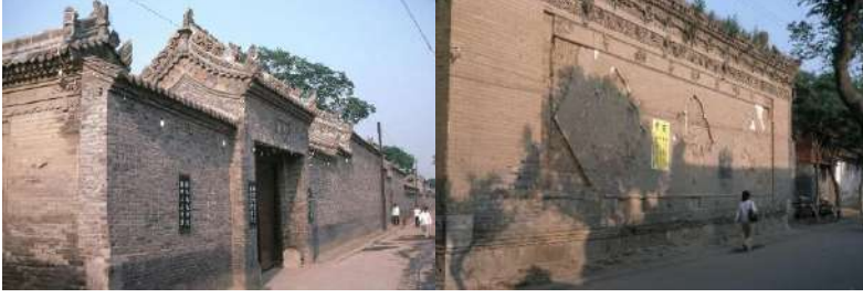
Resim 5. Caminin kuzey kapısı ve duvarları ( https://www.archnet.org )
