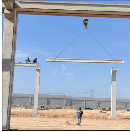
Şekil 1. Yüksekte çalışma sırasında toplu ve kişisel koruma önlemlerinin yetersizliği
