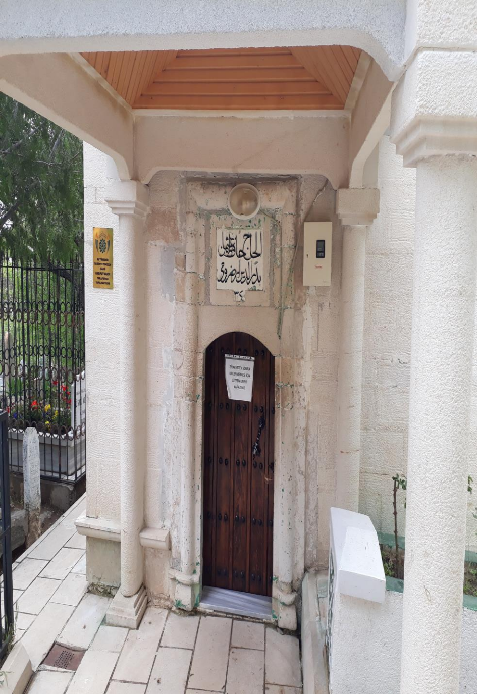
5- Osman Bedrüddin Erzurumi Türbesi (Türbe Giriş Kapısı)
