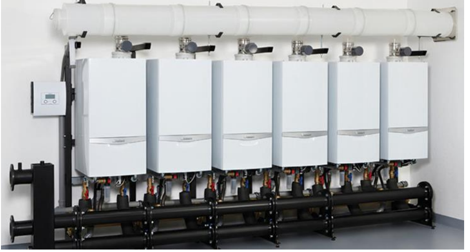
Şekil 12. Kazan, pompa ve baca sisteminin kurulumunun tamamlanmış hali.
