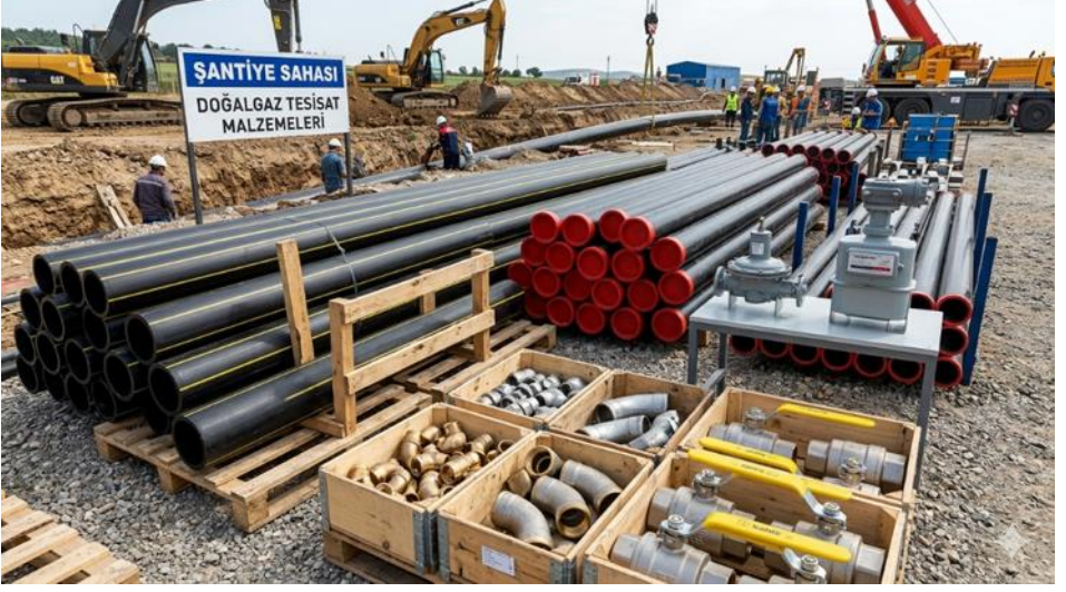
Şekil 10. Şantiye Sahası Doğalgaz Malzeme.
