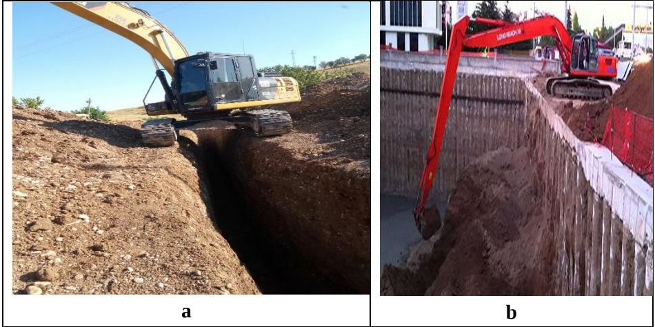
Şekil 3. a. Hendek Kazısı b. Derin Kazı
