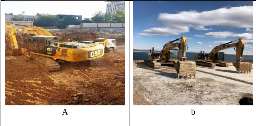
Şekil 1 a. Temel Kazı Çalışması b. Kazılarda Kullanılan İş Makineleri
