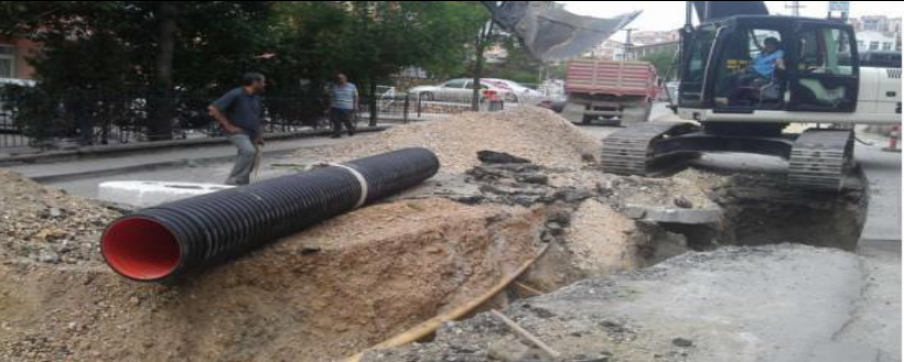
Şekil 9. Kazı çalışması sırasında gerekli tedbirlerin alınmaması (Erdoğan,2018).
