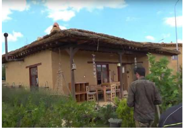
Şekil 6. Şükran Köyü’nde bulunan bir konutun cephesi (Özbaş kişisel arşiv, 2020)
