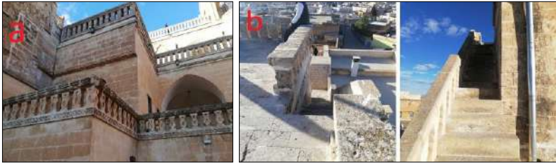
Şekil 13. (a) Midyat evinden gezenek örneği (b) Damlara ulaşan merdiven örneği
