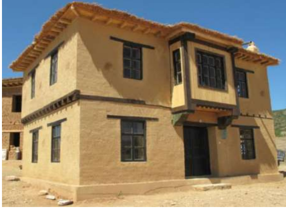
Şekil 12. 2019 Şükran Köyü Konut Örneği (Url-5)
