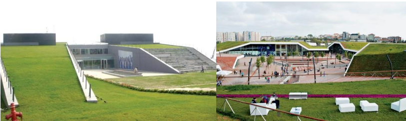
Şekil 1. Turkcell Arge Binası (solda) ve Meydan Alışveriş Merkezi (sağda)
