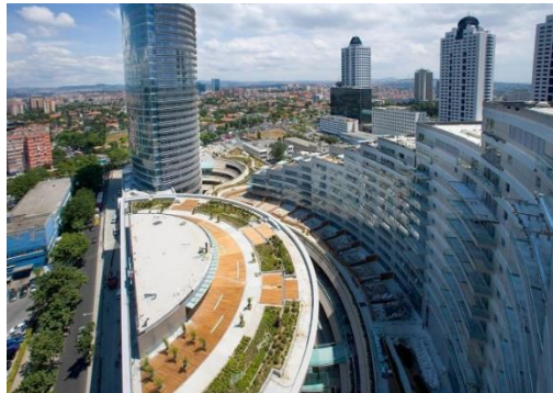
Şekil 3. Ekstensif Çatı Örneği: Kanyon Alışveriş Merkezi
