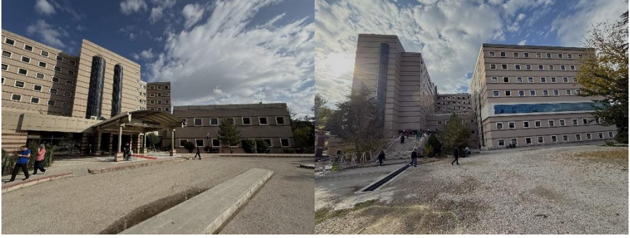
Şekil 5. Mevcut yapının cepheleri
