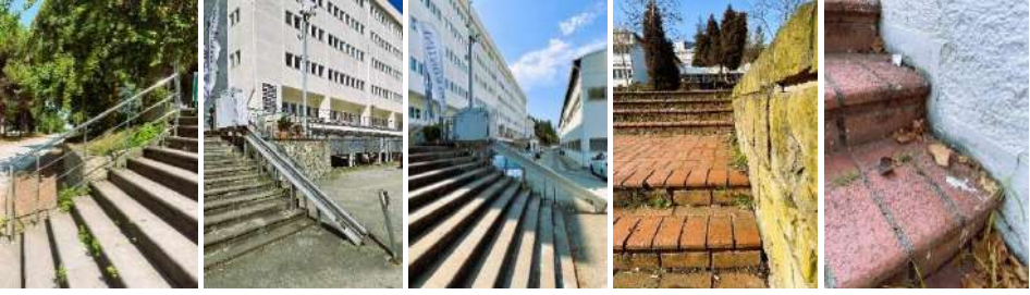
Şekil 6. Korkuluk, platform asansör ve merdiven kurguları (İİBF kantini (ilk üç fotoğraf)) ve basamak burunları
