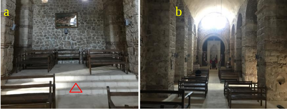
Şekil 11. Naosun batı tarafı görünümü (a), naos doğu tarafı görünümü (b)
