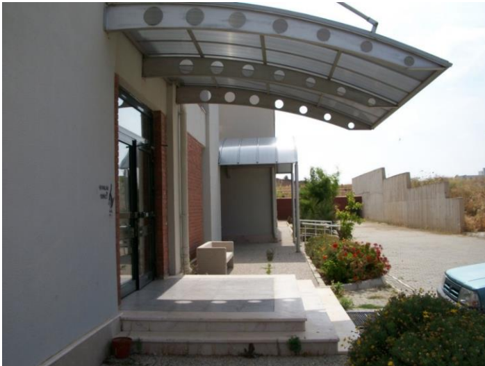
Şekil 34: İzmir Yüksek Teknoloji Enstitüsü Sağlık Merkezi acil servis ana giriş ve rampalı girişi. Foto: A. C. Benli, 2010.
