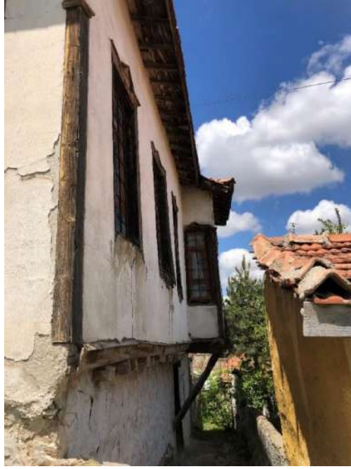
Resim 21: Dışa doğru taşan cumba bölümü, hem içerde alan kazanmak hem de sokağı gözlemleyebilmek amacıyla yapılmıştır. Ahşap hatıllarla desteklenmiştir (Kişisel Arşiv, 2025)
