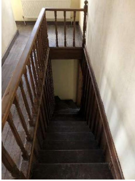
Resim 12: Ahşap malzemedenden yapılmış merdiven ve korkuluk (Kişisel Arşiv, 2025)
