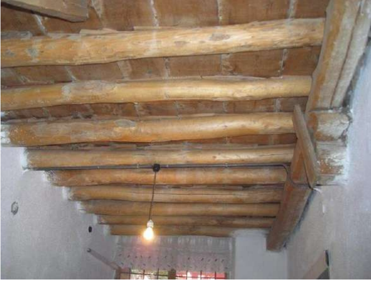
Resim 20: Yapının ahşap kirişleri (Laleli, 2014).
