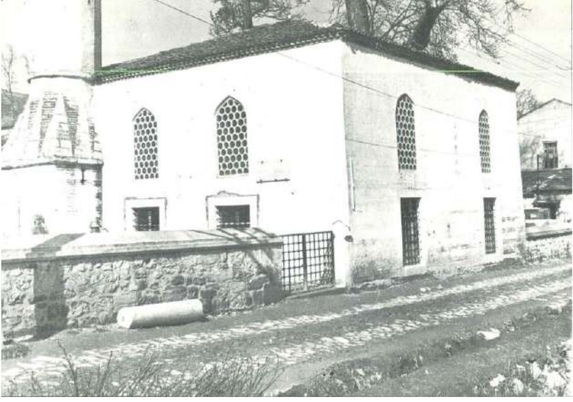
Şekil 7. Dökmeciler Mescidi, güney cephesi, 1988 (Şeker, 2014, s.223)
