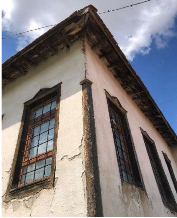
Resim 24: Köşelerdeki taşıyıcı ve estetik değer katan ahşap köşe taşlamaları bulunmaktadır (Kişisel Arşiv, 2025)
