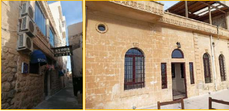
Şekil 3.8 Stone Otel; solda güney cephesi, sağda 2. Kat terası güney cephesi (KA, 2023)
