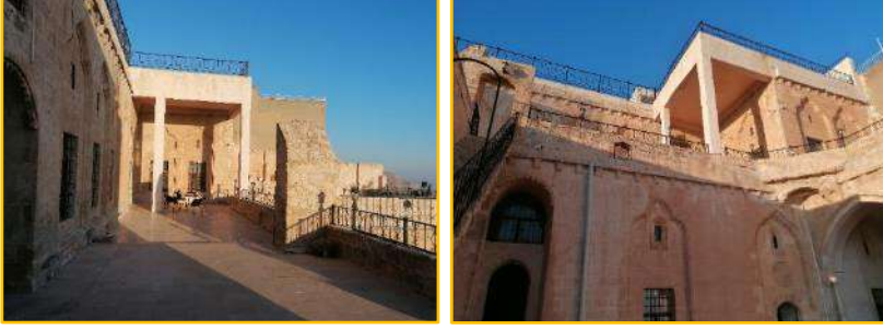
Şekil 5.31 Kasrı Abbas Pansiyon 2. Kat terasındaki betonarme eklenti
