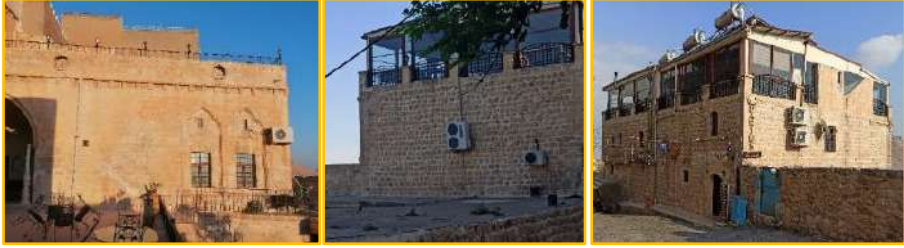
Şekil 6.6 Klima dış ünitesinin görünür cephelerde olduğu örnekler; soldan sağa Kasrı Abbas Pansiyon, Darius batı ve doğu cephesi
