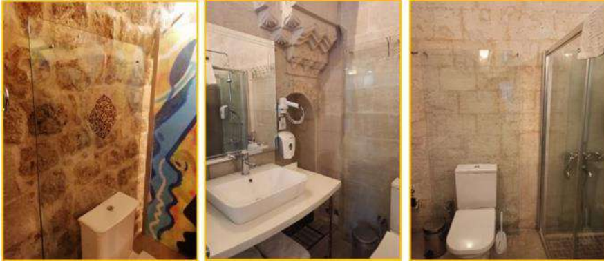
Şekil 5.52 Islak hacimde evye-lavabo gibi elemanlarla taş duvar arasında cam uygulaması; solda Tarihî Selçuklu Konağı, ortada ve sağda Mardin Osmanlı Konağı
