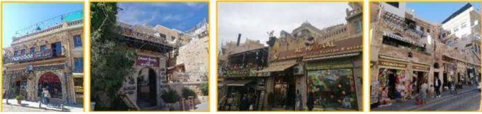
Şekil 6.2 İşlev değişiklikleri ile kentte kafe ve restorana dönüştürülmüş yapı örnekleri
