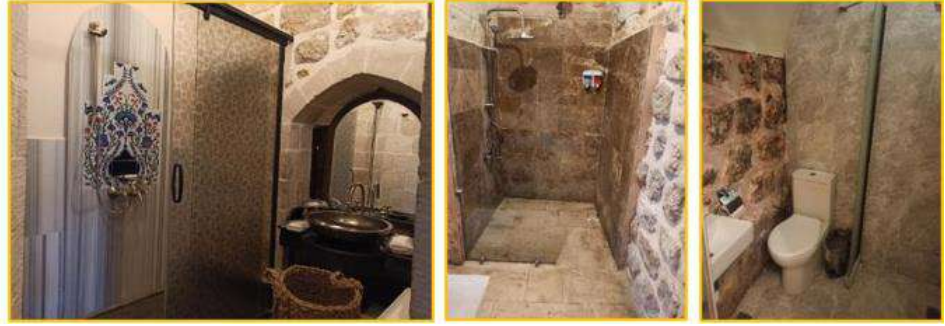
Şekil 5.48 Islak hacim taş yüzeylerinde kısmi kaplamanın uygulanması soldan sağa; Mardius Tarihî Konak, Darius Konağı, Merdin Butik Otel
