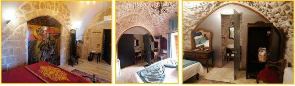
Şekil 5.43 Odada bulunan nişin kapatılarak ıslak hacim oluşturulması örneği; soldan sağa Osmanlı Konağı Otel, Fairouz Otel
