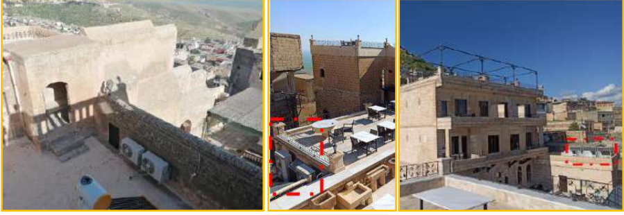
Şekil 6.5 Klima dış ünitesinin teras veya damda konumlandırıldığı yapı örnekleri; soldan sağa Maristan Tarihî Konak, Gazi Konağı Otel cephesi, Gazi Konağı Otel damı
