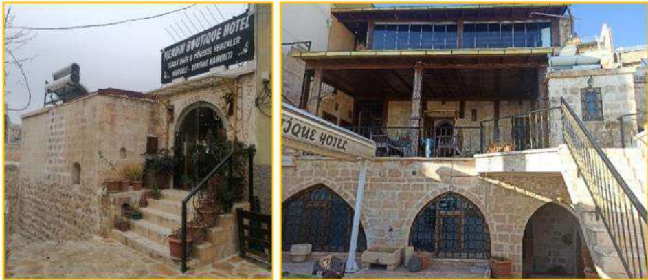
Şekil 3.20 Merdin Butik Otel (KA, 2023)
