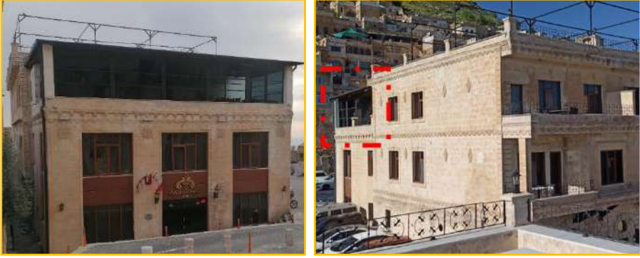
Şekil 5.21 Gazi Konağı Otel damının sonradan camekân alana dönüştürülmesi
