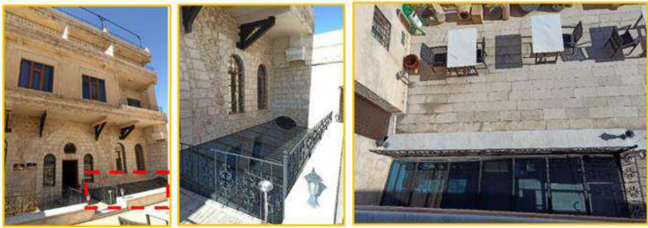
Şekil 5.27 Gazi Konağı Otel açık büfe alanı üstünde cam tavan uygulaması
