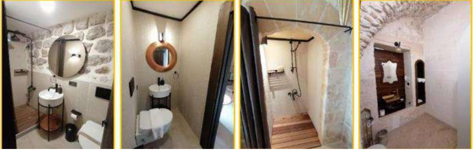
Şekil 5.50 Islak hacim ahşap-taş kaplama malzeme örnekleri sağ Fairouz Otel, diğerleri Mirsoum Otel
