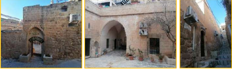
Şekil 5.17 Soldan sağa; Dara Konağı giriş cephesinde, avluya bakan cephede, doğu cephesinde klima dış ünitesi kullanımı
