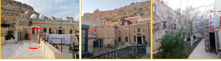
Şekil 5.13 Klima dış üniteleri konumu soldan sağa; Fairouz Konağı, Mardin Osmanlı Konağı Otel, Maridin Otel
