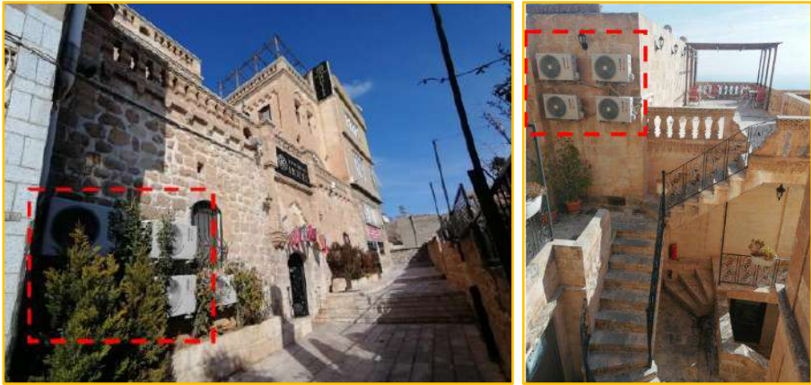
Şekil 5.18 Zinciriye Otel solda güney cephesinde klima üniteleri, sağda terasa bakan cephede klima üniteleri
