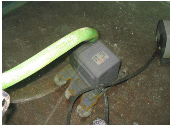
Şekil 17. Akvaryum ile filtrasyon ünitesi arasındaki su sirkülasyonunu sağlayan motorlar.
