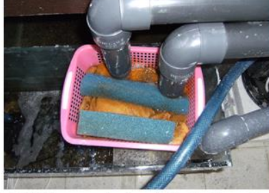
Şekil 16. Filtrasyon tankındaki elyaf ve süngerler.
