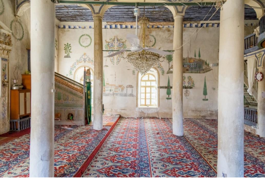
Resim 10; Afyonkarahisar Dazkırı Kızılören Köyü Eski Camii, batı duvarı
