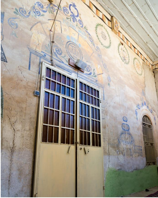
Resim 16; Dazkırı Kızılören Köyü Eski Camii, son cemaat yeri, güney duvarı batı bölümü
