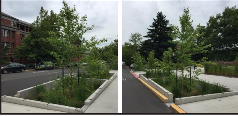
Şekil 17: Yağış Suyu Bitki Şeridi Örneği Eugene, US (Hepcan, 2019)
