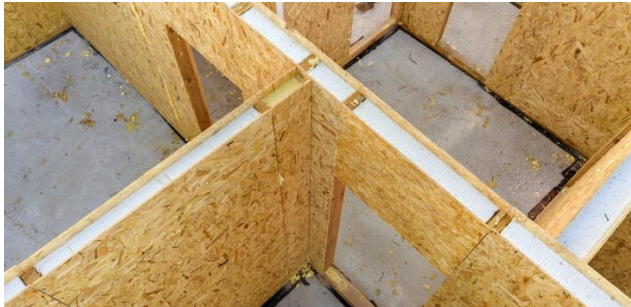
Şekil 3: SIP panel duvar görünümü (URL 4)
