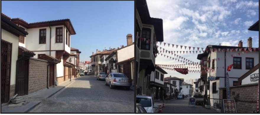
Resim 5. Mengüç Caddesi Doğu Bakış (Özeren,2018) Resim 6. 1. Mengüç Caddesi Batı Bakış (Özeren,2018)
